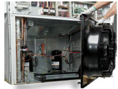
Slide out Condenser Fan
